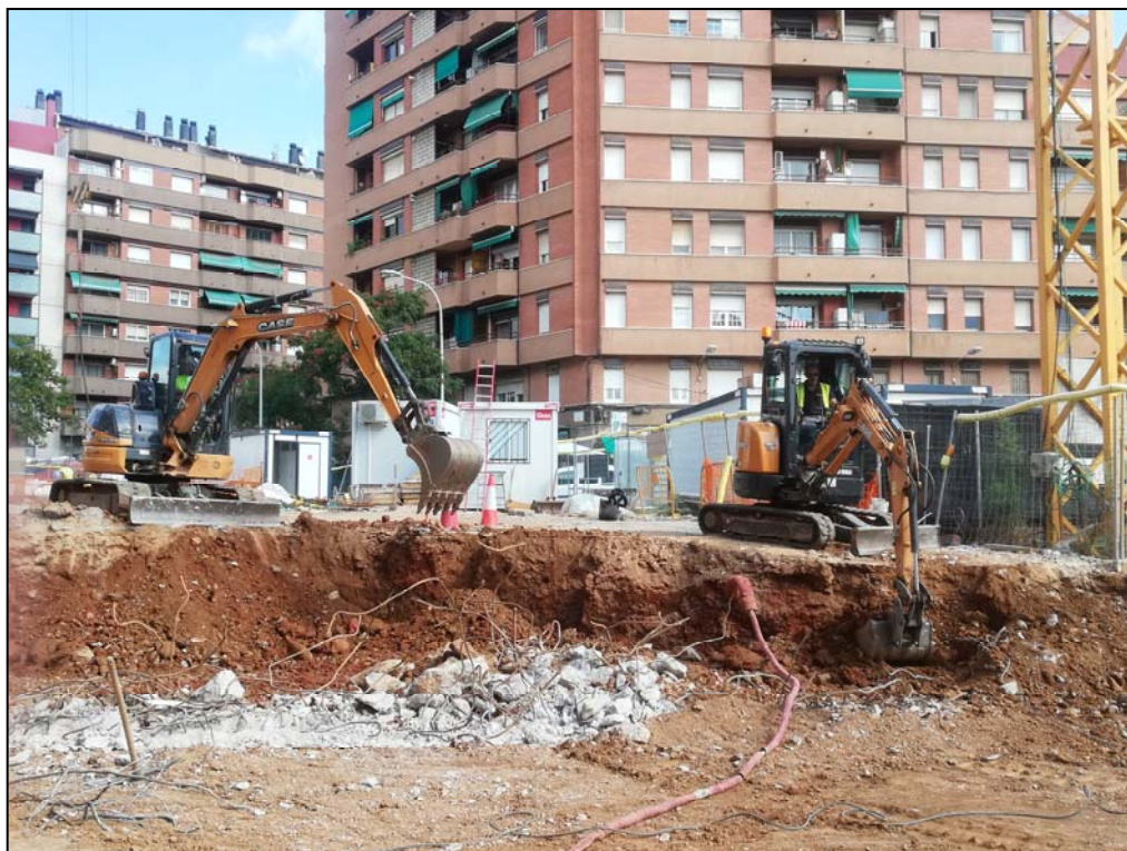
Fotografia 3. Rebaix de terres general.
