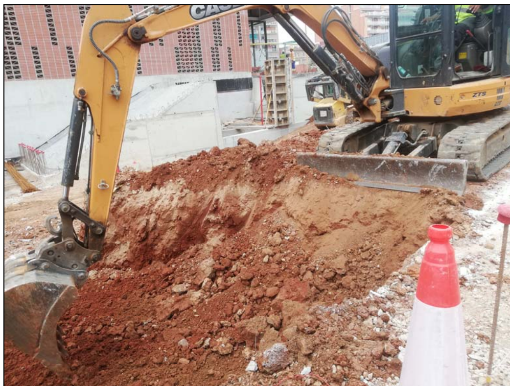
Fotografia 4. Detall del rebaix de terres general.
