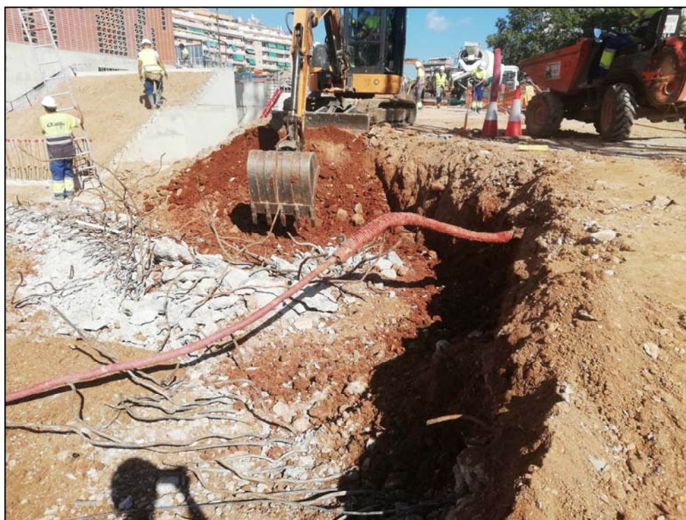
Fotografia 2. Rebaix de terres general.
