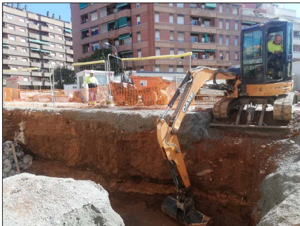
Fotografia 1. Rebaix per encabir-hi les escales
