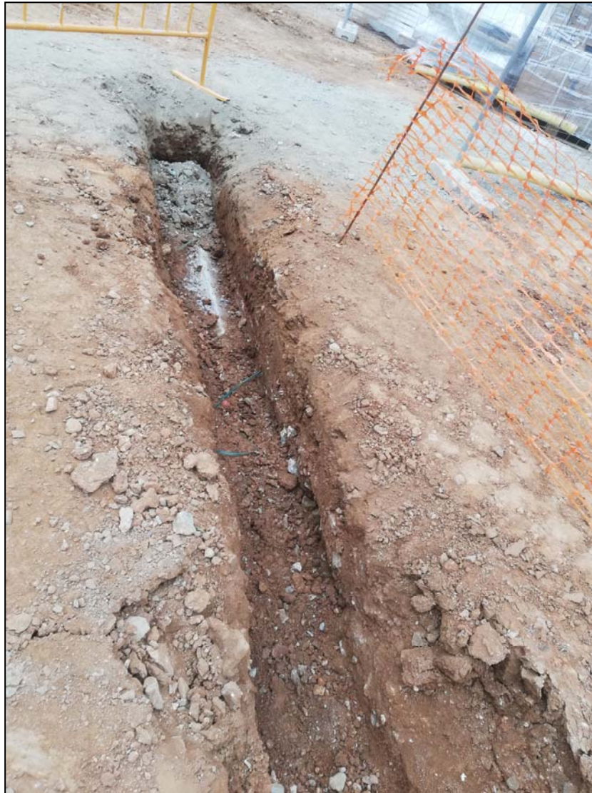
Fotografia 7. Detall de la rasa per la xarxa d'enllumenat.
